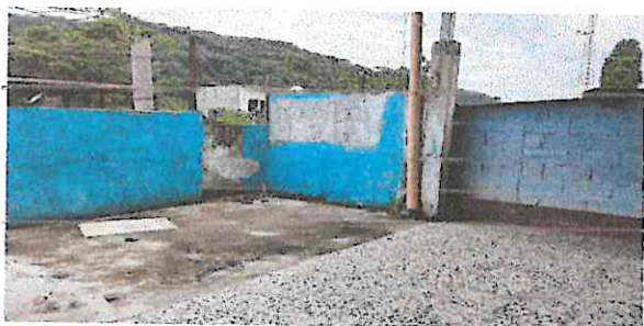
Foto 5: REPARACION DE MURO PERIMETRAL DE BLOCK, REFUERZO DE COLUMNAS, SOLERAS INTERMEDIAS
