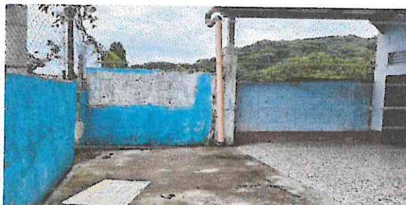
Foto 6: REPARACION DE MURO PERIMETRAL DE BLOCK, REFUERZO DE COLUMNAS, SOLERAS INTERMEDIAS
