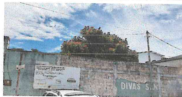
Foto 4: REPARACION DE MURO PERIMETRAL DE BLOCK, REFUERZO DE COLUMNAS, SOLERAS INTERMEDIAS
