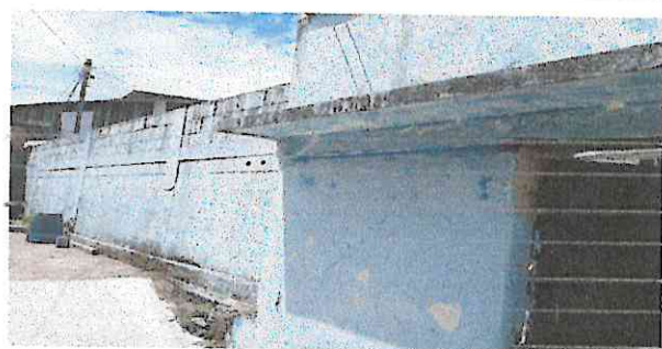
Foto 1: REPARACION DE MURO PERIMETRAL DE BLOCK, REFUERZO DE COLUMNAS, SOLERAS INTERMEDIAS
